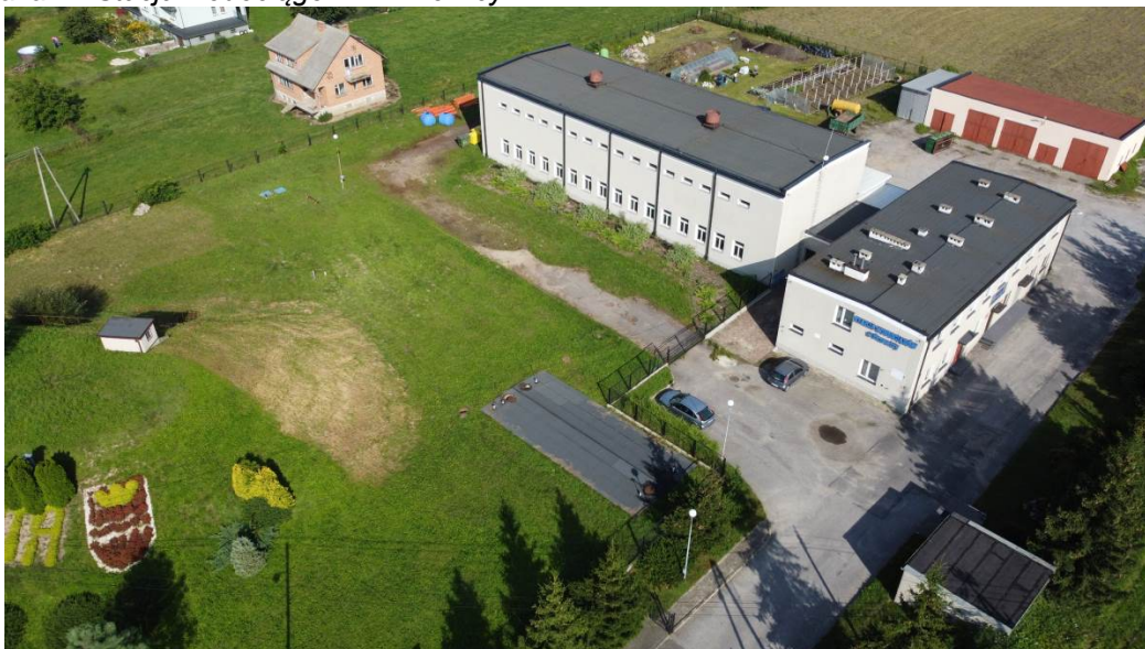
Fotografia 14 Stacja wodociągów w Drzewicy
