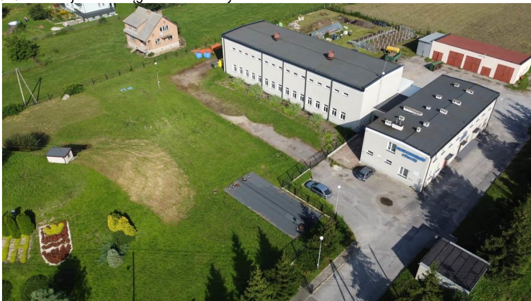
Fotografia 14 Stacja wodociągów w Drzewicy
